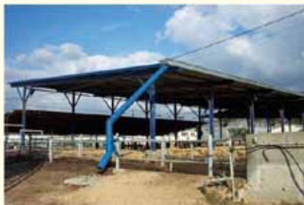
הרפת האקולוגית - מערכת מרזבים למניעת שטיפת הזבל לסביבה
